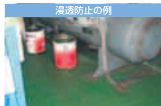
浸透防止の例 コンプレッサー室内の油浸透防止加工
