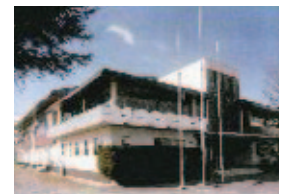
ガラス窓の遮熱・断熱塗料の塗布を施工した体育館
