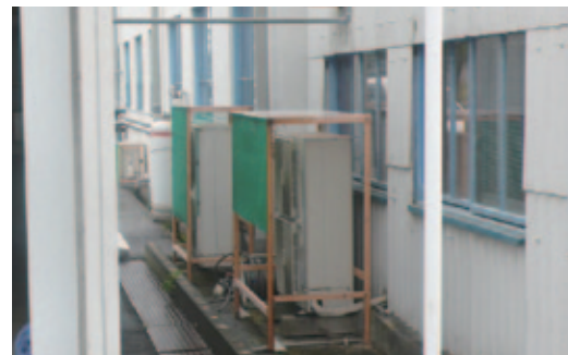
室外機に“よしず”を設置
