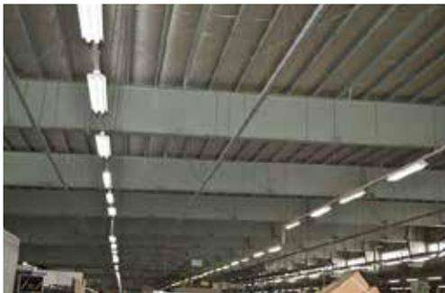
工場の LED 照明。ワイヤー吊り下げタイプでは LED 灯を使い、ダクトタイプでは LED 器具を取り付け
