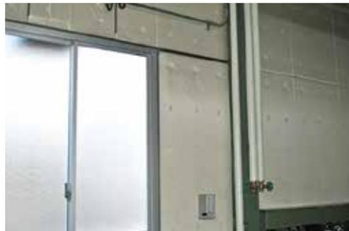
プレス棟の壁面には防音材が使われている
