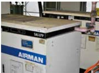
湯本工場のコンプレッサー (写真は 37kW2 基)
