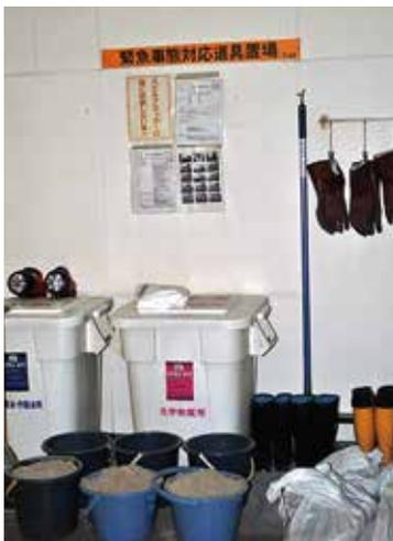
廃液が漏れる事故を想定した防液堤を作る器材。定期的な訓練も実施している
