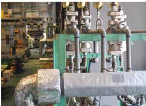
断熱ジャケット化された蒸気バルブ配管
