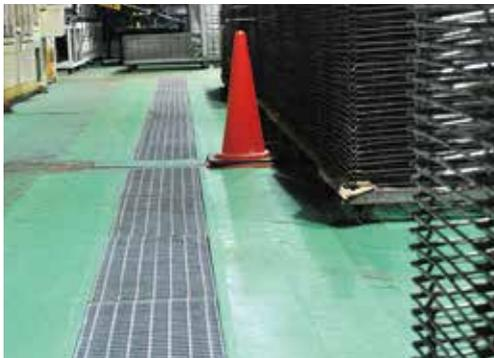
埋設されていた廃液輸送管をトレンチ（溝）に通してメンテナンス性を向上
