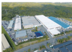
鹿島システム工場 (2024年度LNG導入予定)
