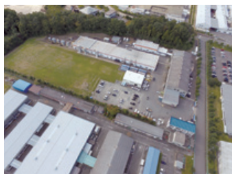
クレート工場 (2023年度LNG導入予定)
