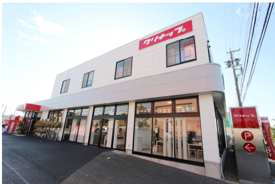
豊橋ショールーム外観
