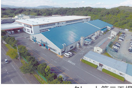
クレート第二工場
