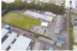
クレート工場
