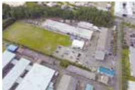
クレート工場
