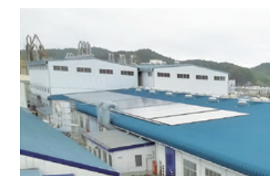
太陽光発電を設置した湯本工場
