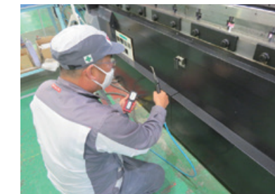
省エネパトロールでのエアー漏れチェック
