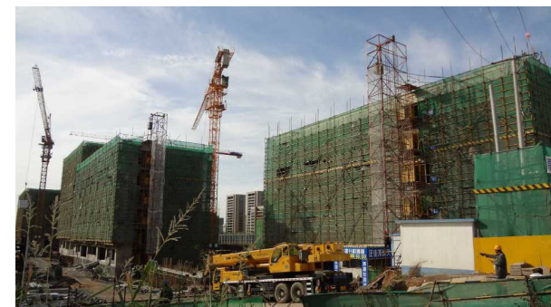
瀋陽揮南地区マンション現場
