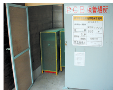
PCB廃棄物保管庫
