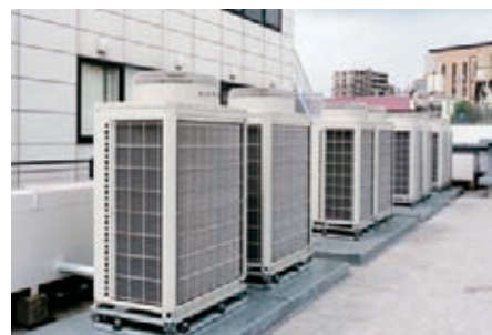
高効率空冷ヒル用マルチヒートポンプシステム
