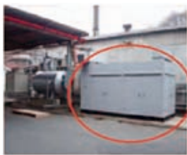
蒸気タービン式コンプレッサー(蒸気駆動式空気圧縮機)
