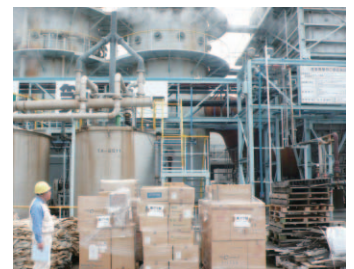
廃油中間処理場の視察
