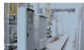
ESCO事業による集塵機用インバーター導入
