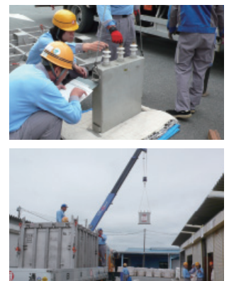
高圧コンデンサ処分のために収集運搬車へ積み込みする様子
