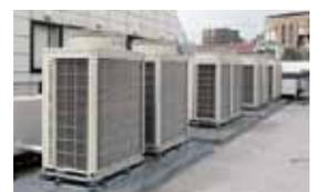
高効率空冷ビル用マルチヒートポンプシステム
