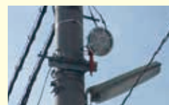
■ 夜間作業場の投光器LED
