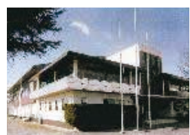
ガラス窓の遮熱・断熱塗料の塗布を施工した体育館
