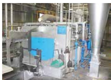
木くずボイラー
