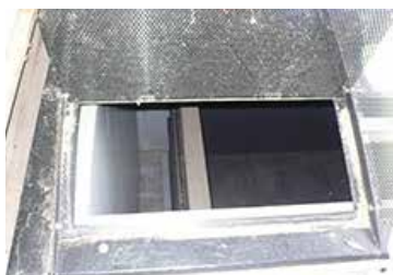
緊急時薬液回収槽
