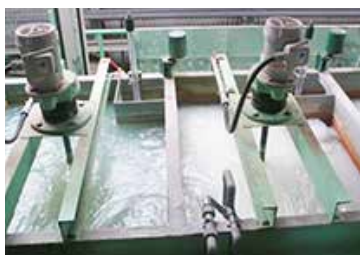
廃液処理施設
