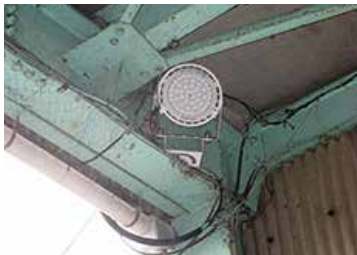
暗く作業しにくかったプラットホームにLED照明を設置
