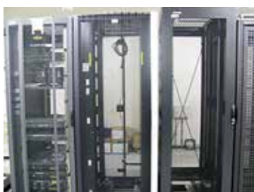
9割のサーバが移管されたので、サーバラックに空間が目立つ
