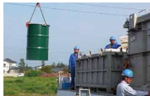
PCB廃棄物搬出状況
