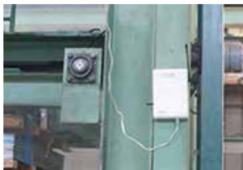
デマンド監視モニター
