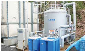
工業用水のタンク (上) ろ過装置 (下)
