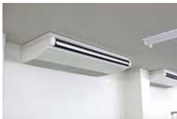
マシン室の空調機。以前は床置き型の大型空調機を使っていた
