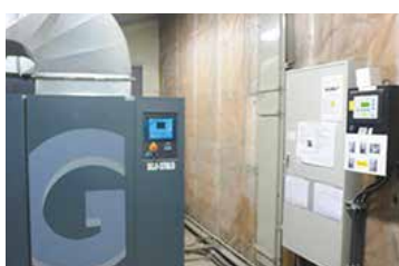
工場の動力源になるコンプレッサー
