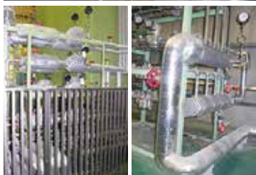
ボイラー室、乾燥炉のパイプなどを断熱化
