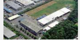
クレート工場
