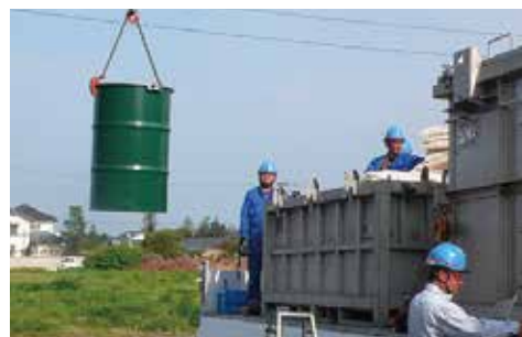
PCB廃棄物搬出状況
