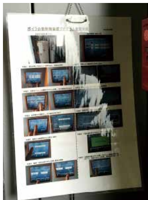
ボイラー台数制御プログラムの設定手順
