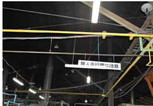
新設された通路照明
