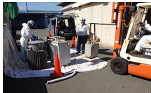
微量PCBを含む変圧器、コンデンサの搬出
