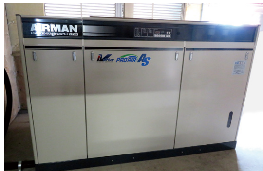
コンプレッサーモインバーター式の省エネタイプを設置
