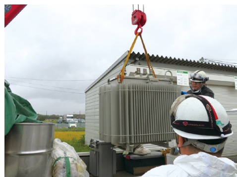
微量PCBを含む変圧器、コンデンサの搬出
