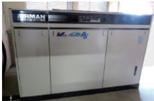
コンプレッサーはインバーター式の省エネタイプを設置
