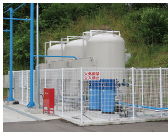
LPGガスタンク (湯本工場)
