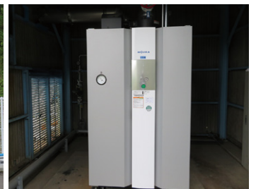
蒸気ボイラー (湯本工場)
