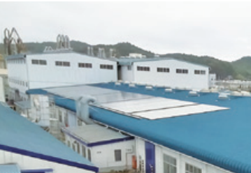
太陽光発電を設置した湯本工場
