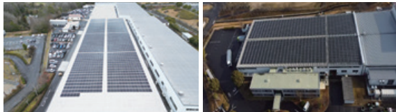
工場に設置した太陽光発電設備（左：岡山工場、右：津山工場）
