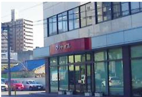
〔広島ショールーム外観〕
