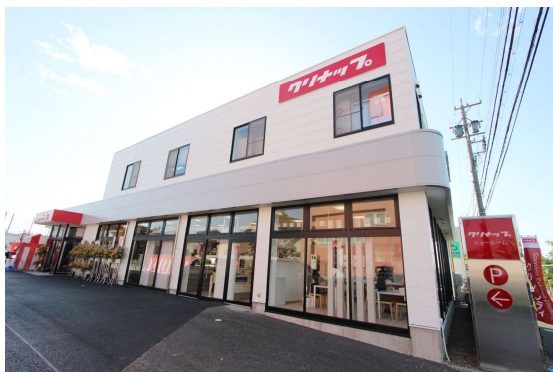
豊橋ショールーム外観
