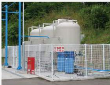
LPGガスタンク（湯本工場）
