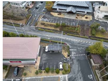
津山ショールームのソーラーカーポート
