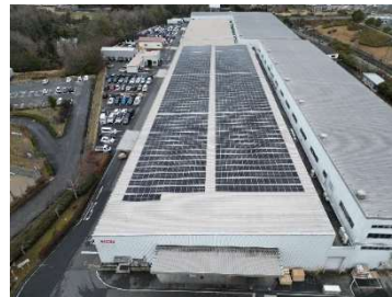
岡山工場の太陽光パネル
